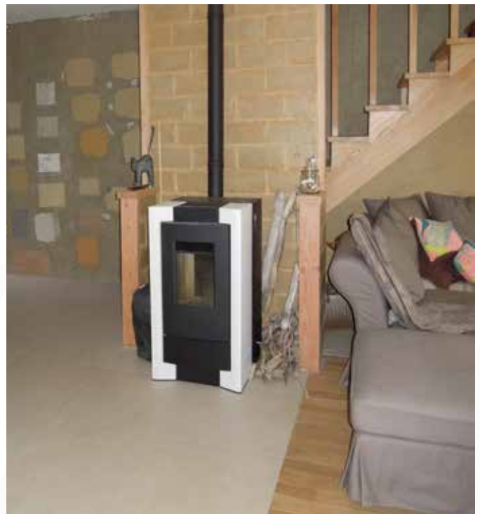
Des parois en terre crue ont été montées à proximité des poêles à bois pour une meilleure accumulation/restitution de la chaleur produite. - Photo © MC Couthenx
